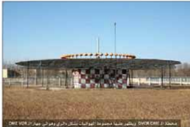
محطة الـ VOR/DME وتظهر عليها مجموعة الهوائيات بشكل دائري وهوائي جهاز الـ VOR/DME
