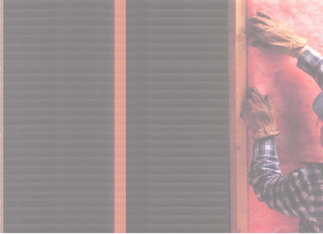
صورة (١) طرسقة تثبيت الصوف الصخري بين العوارض الخشبية وقبل وضع الشبك عليه
