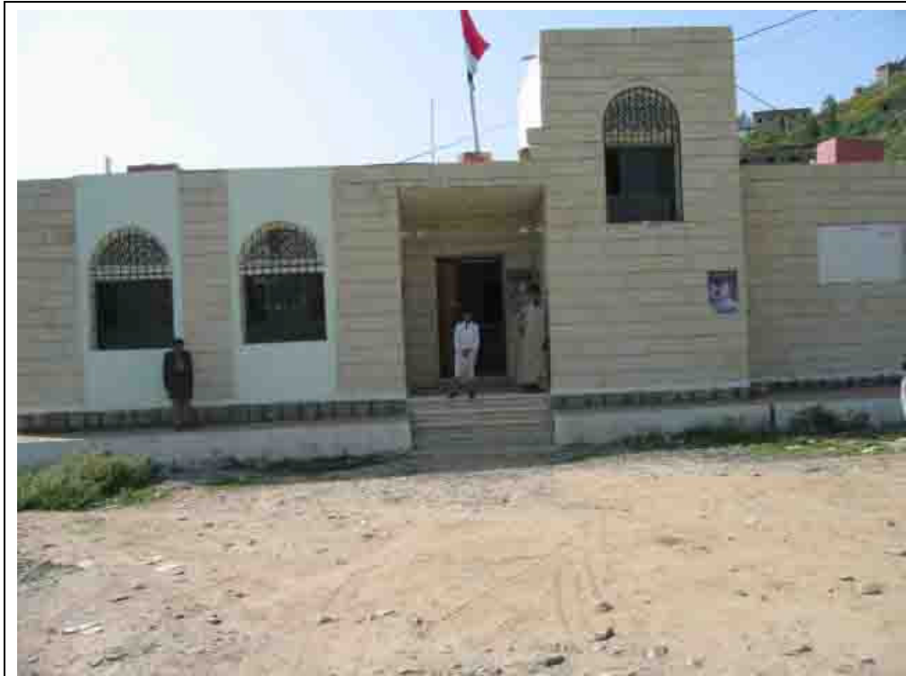
الشكل رقم 2-2: مركز عمر الصحي، مديرية عمر، محافظة صعدة
